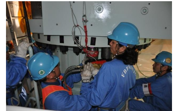
燃料出入孔ドアバルブ取付ボルト締結作業
