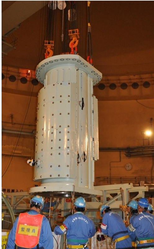
上部案内筒吊りこみ作業
