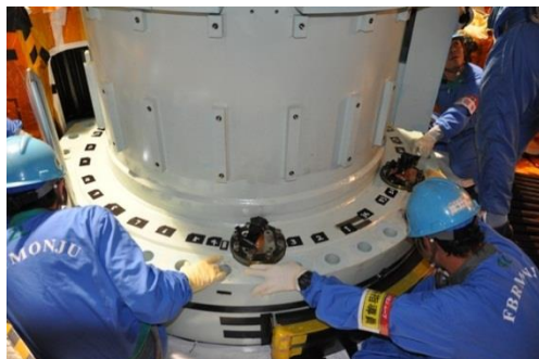
上部案内筒据付状況
