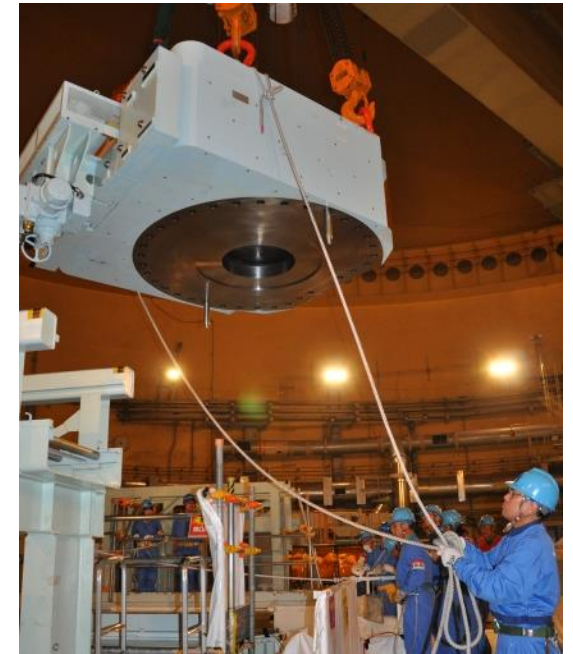
上部案内筒への燃料出入孔ドアバルブ取付け作業
