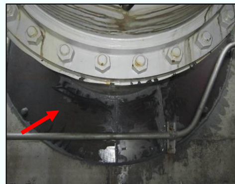
建屋貫通部シール施工
