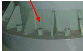
タンク基礎ボルト部
