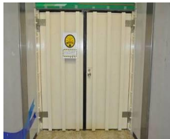
扉へのシール施工
