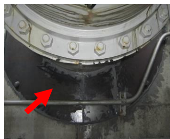
建屋貫通部へのシール施工
