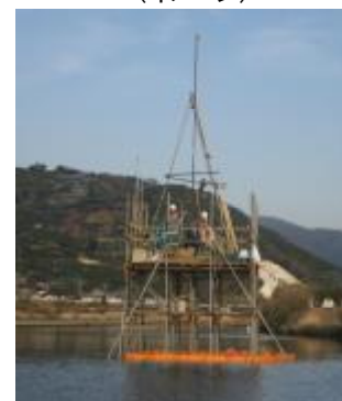
水上ボーリング調査 (イメージ)
