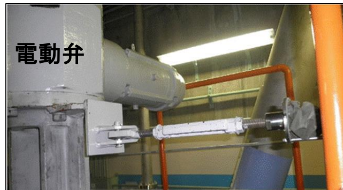
A余熱除去ポンプ燃料取替用水 タンク側入口止め弁(電動弁)
