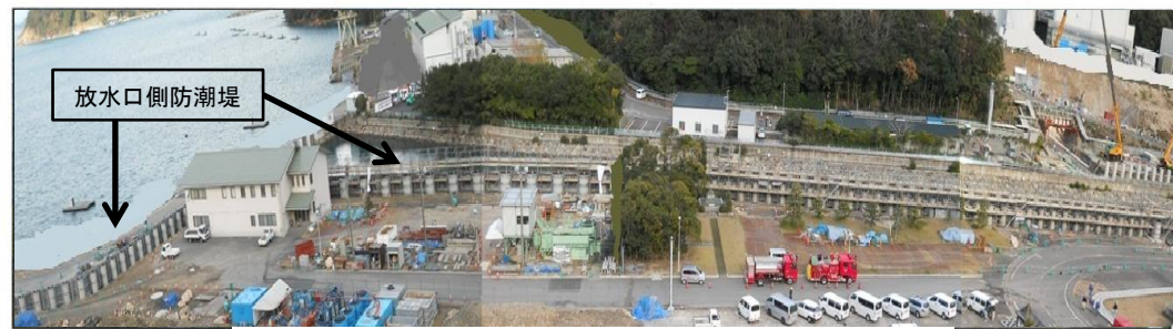
放水口側防潮堤
