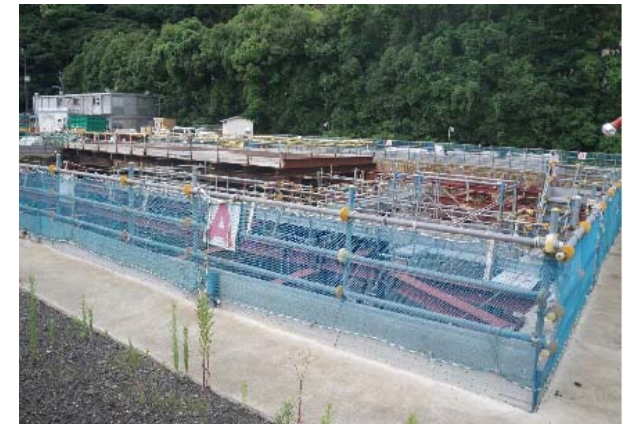
高浜発電所現地状況
