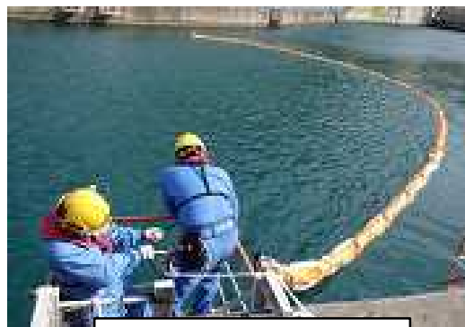
シルトフェンス設置
