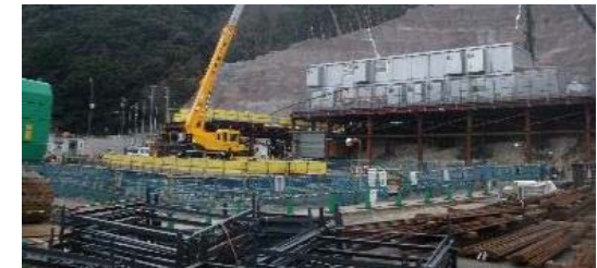
高浜発電所現地状況（作業用エリア拡張工事）
