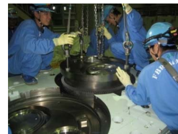
①炉外燃料貯蔵設備 床ドアバルブの点検 (平成29年7月～10月)
