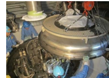
②燃料缶詰設備容器開放点検 (平成29年9月～)
