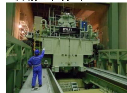
③燃料出入設備の動作試験 (平成29年10月～)
