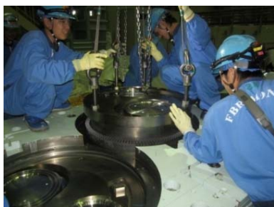
床ドアバルブ (6連式) 分解点検 (2017年7月~10月)
