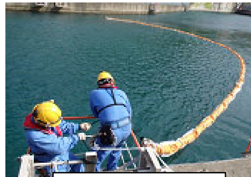
シルトフェンス設置
