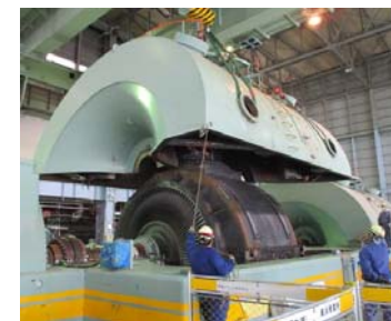
【タービン解体】
