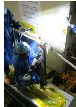
金属試料採取 (手すり)
