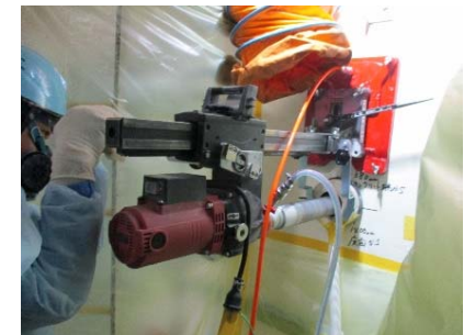
コンクリート 試料採取(壁)
