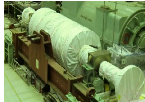
低圧タービンロータ解体後
