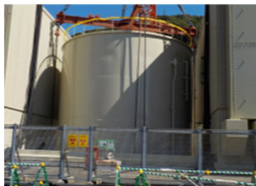
タンク据付(2019.9月)
