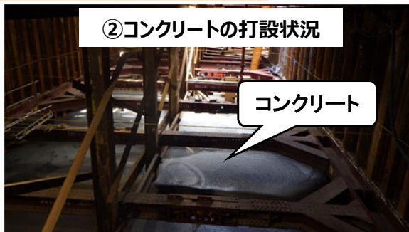
防潮堤構築工中
