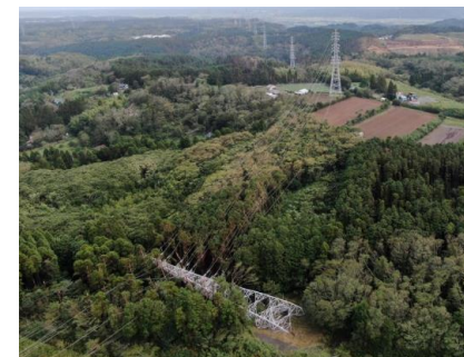
鉄塔設備の倒壊（君津市）
