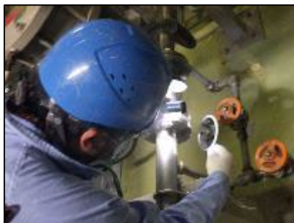
手鏡による細部の点検
