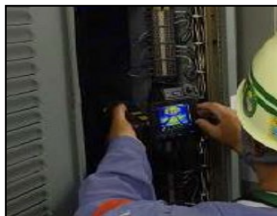
サーモグラフィによる端子接続部の点検
