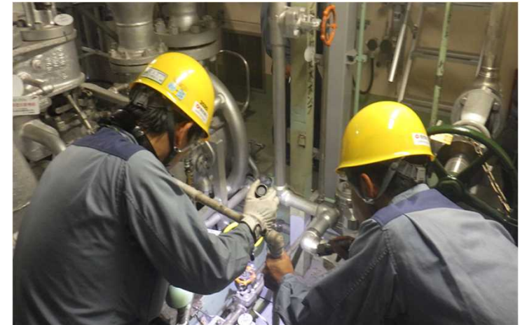
(火力分野の点検状況)
