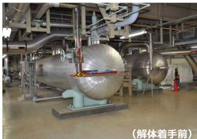
高圧給水加熱器の解体
