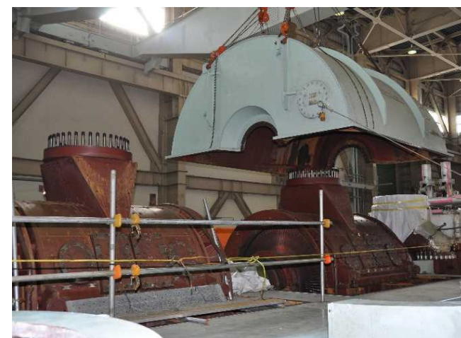
タービンの解体
