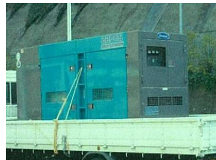
【220KVAディーゼル発電機】
