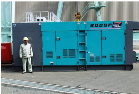
【800kVAディーゼル発電機】
