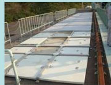
海水配管通路への海水侵入に対する水密性を有していないため蓋取り付け方法を改善
