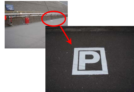
改善事例2: ポンプ設置場所をマーキング
