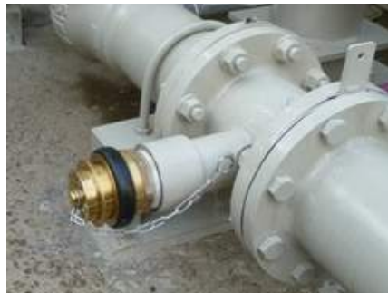
改善事例1: 復水タンクの接続口
