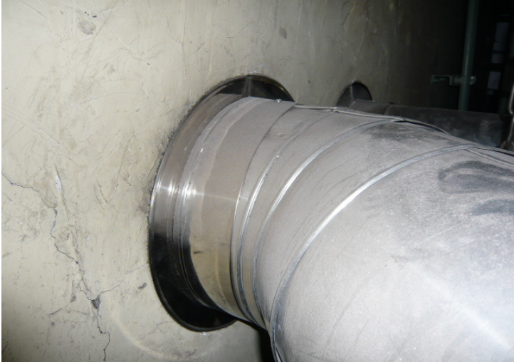
シール施工前
