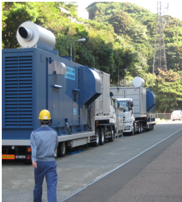
空冷式非常用発電装置
