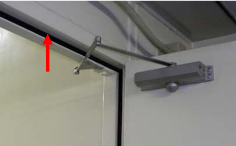
シール施工後
