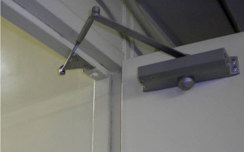
シール施工前
