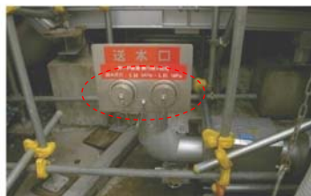
原子炉建屋 消火栓用送水口
