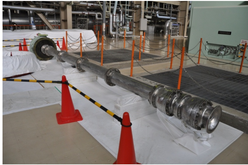
代替ポンプ本体
