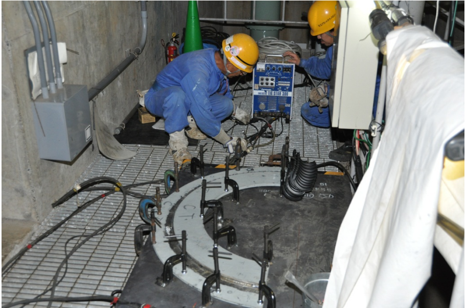
止水板(加工中)
