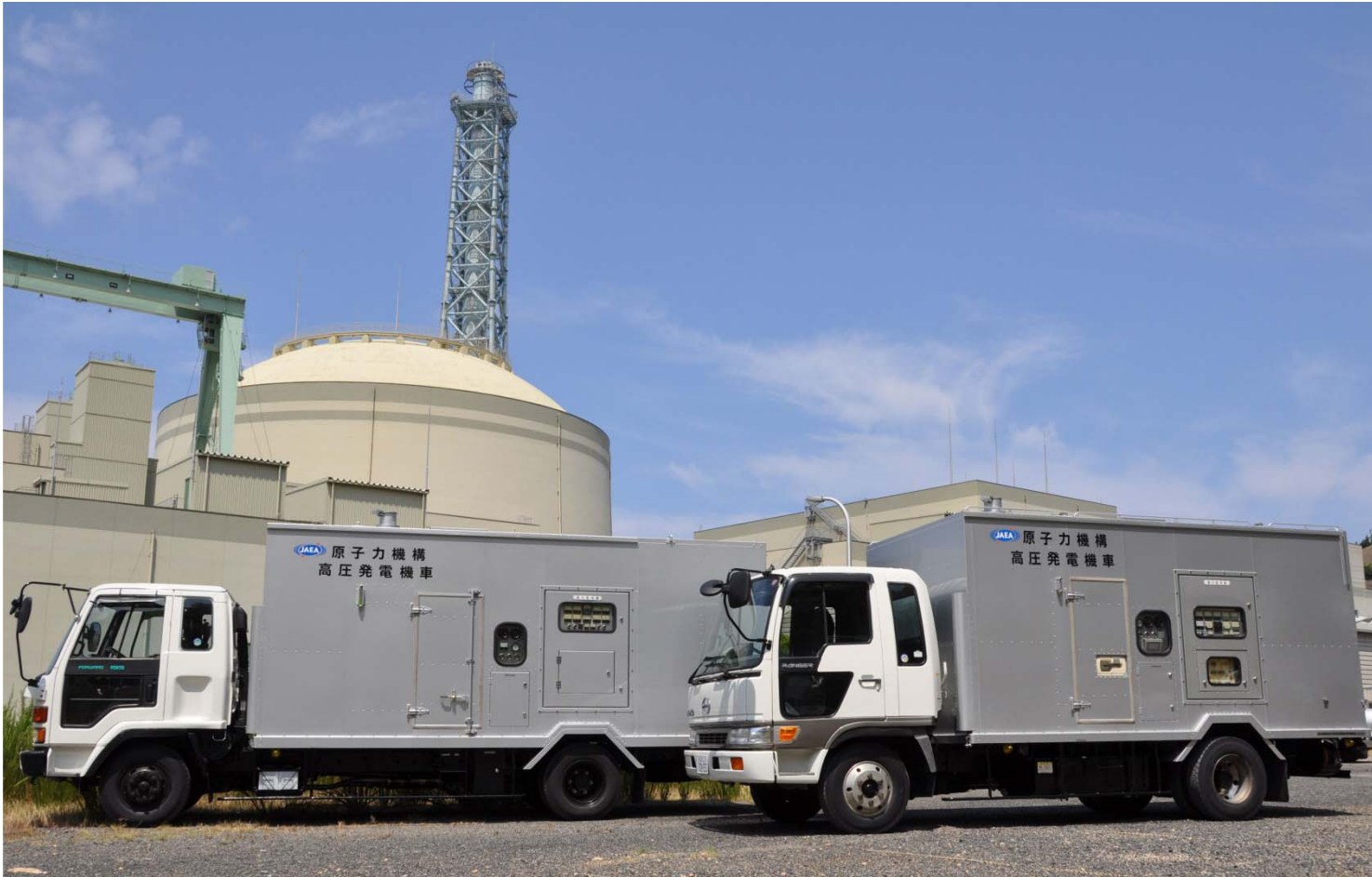
電源車(300kVA×2台)に変更
