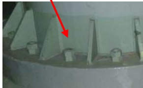
タンク基礎ボルト部
