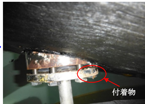
保温材取り外し後の加温用蒸気出口配管フランジ部の状況
