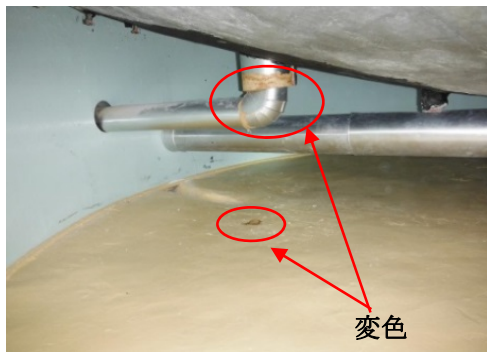
保温材カバー及び床面の状況
