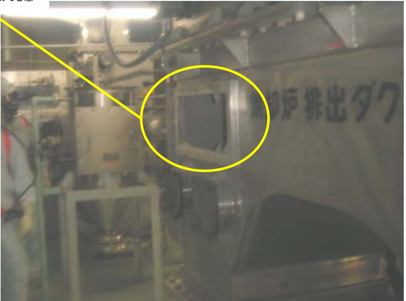
破損したのぞき窓
