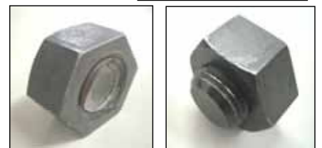
折損したボルト、ナット
