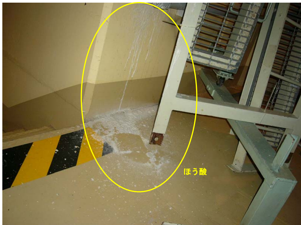
原子炉格納容器地下 2 階床面
