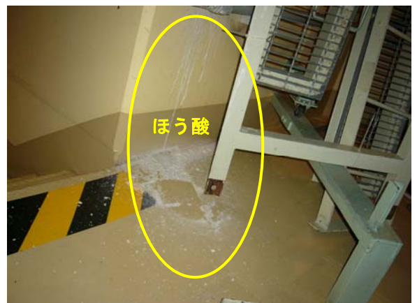
原子炉格納容器地下2階床面
