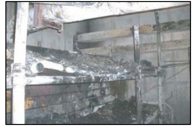
火災後の棚中段の写真
