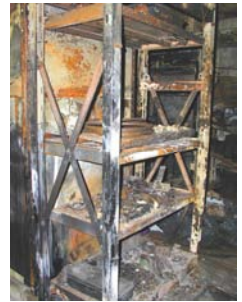
火災後の③工具棚の写真
