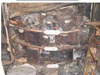
火災後の塗装棚の写真
