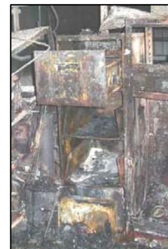
火災後のキャビネットの写真
