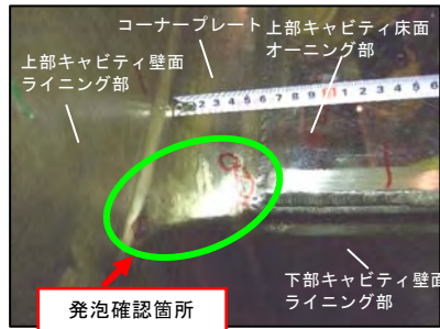
発泡確認箇所① (コーナープレート部)
