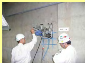
コアボーリングの状況
