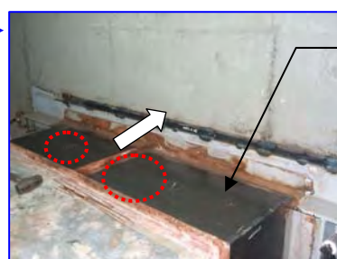
＜補修後の状況＞
