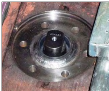
＜回り止めピン対策溶接後の状況＞
