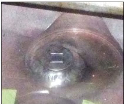
＜閉止栓対策溶接後の状況＞
