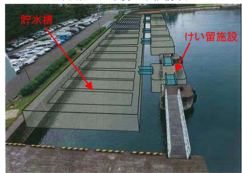
【 2号機海水貯水槽完成イメージ図 】 （平成20年度から継続中）
