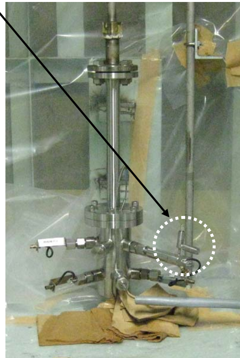
漏えい後の状況 (H21. 10. 8撮影)
