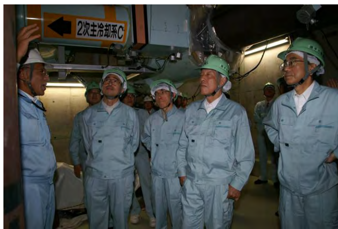
2次系配管室における改造工事の状況確認 (平成17年10月12日)
