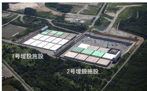
日本原燃 (株) 六ヶ所低レベル放射性廃棄物埋設センター
