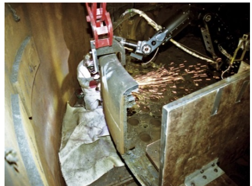
大型機器解体の様子
