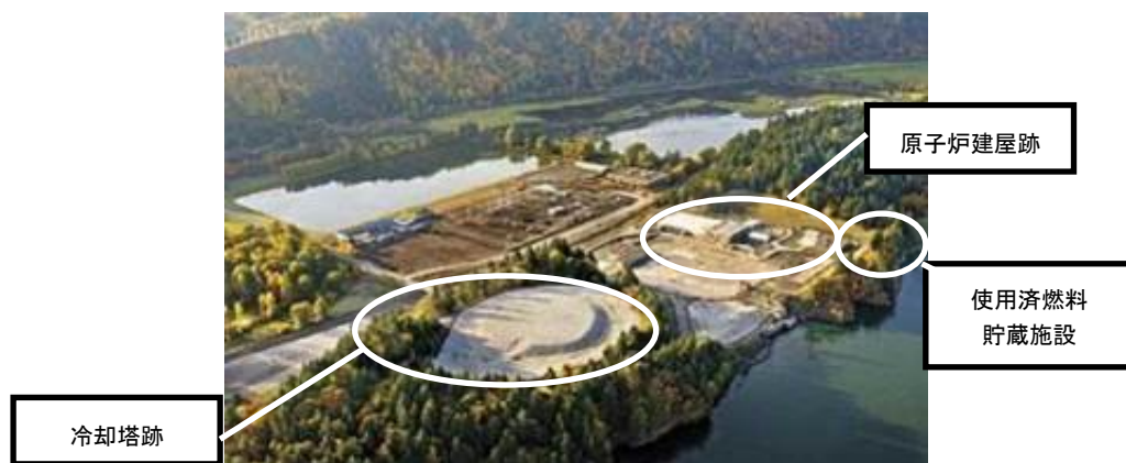
周辺の様子（廃止措置後）
