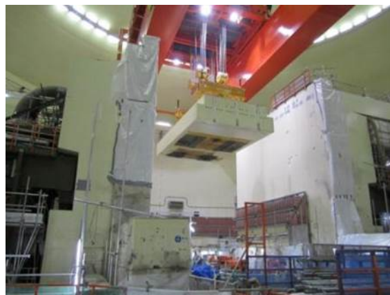
発電所内コンクリート構造物の 解体状況
