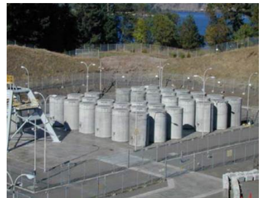
コンクリートキャスクによる 使用済燃料の貯蔵
