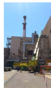
建屋解体の様子
