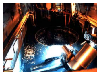
水中遠隔解体
