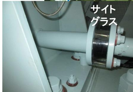
発電機と配管の溶接部に異常なし、破損したサイトグラスと曲ったボルトは交換
