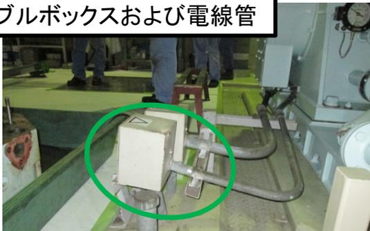
変形が認められたが、内部のケーブルの導通確認等の結果、ケーブルに異常なし
