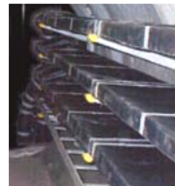
<防火シート施工イメージ>
