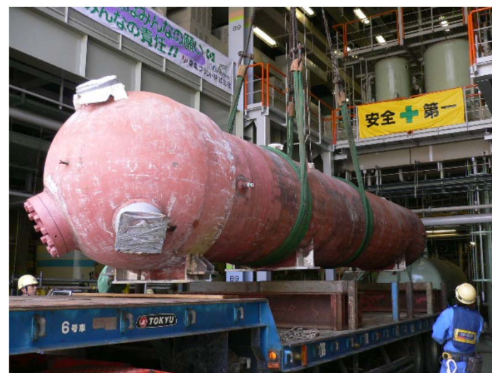
タービン建屋内機器解体（平成29年度下期～） ※写真は過去の熱交換器取替工事
