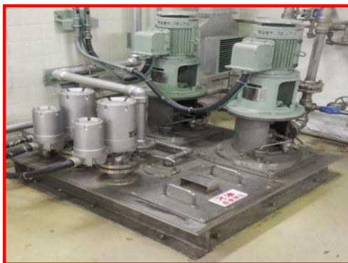
排水ピットの除染 (タービン建屋 1 階、H29.5～)
