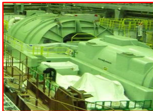
タービン・発電機解体 (タービン建屋 3 階、H29下期～)
