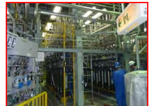
制御棒駆動水圧ユニット解体 (原子炉建屋 1 階、H29下期～)
