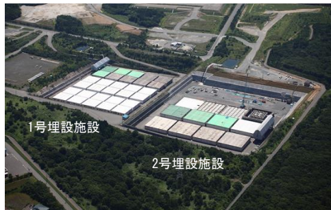
日本原燃（株）六ヶ所低レベル放射性廃棄物埋設センター
