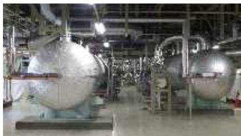
高圧第1、2給水加熱器（解体前）
