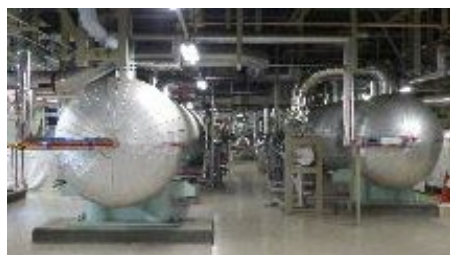
高圧第1、2給水加熱器（解体前）
