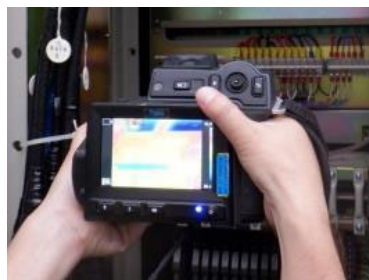
【サーモグラフィによる点検状況】
