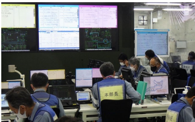
高浜発電所（9/24） 緊急時対策所
