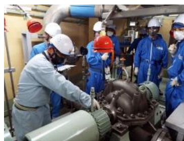
【回転機器の振動確認の状況】
