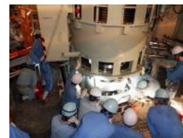
【現場パトロールの状況】
