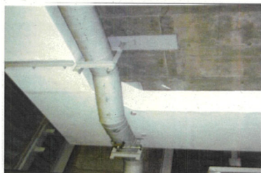
防火シート+1時間耐火壁施工状況
