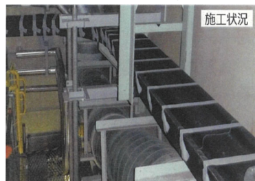
防火シート施工状況
